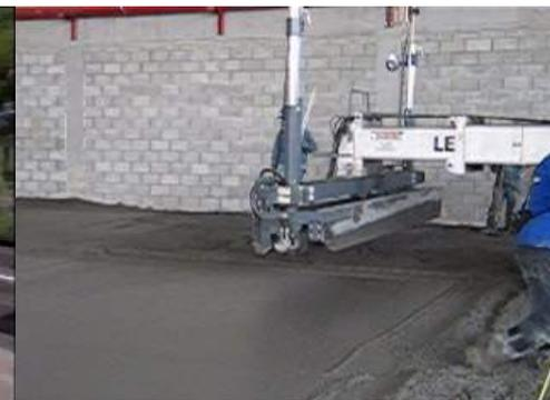
**Cuando se coloca hormigón con reglas y rodillos se debe vibrar antes del paso del equipo de colocación**
