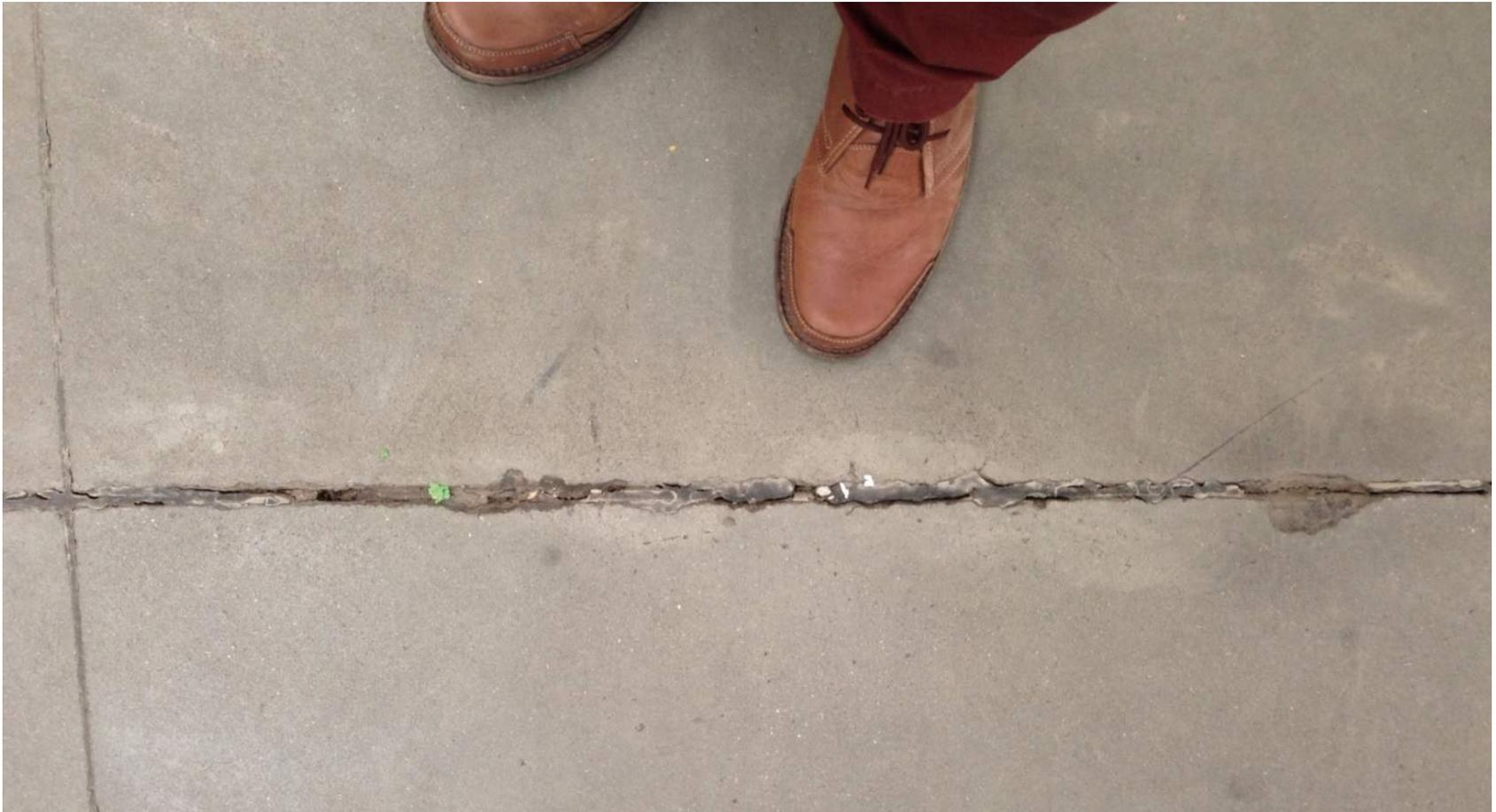
*Detalle del estado de una junta constructiva en un homecenter luego de un par de años de uso.*
