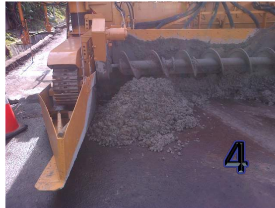
Secuencia de colocación de concreto sobre sensores de medición.
